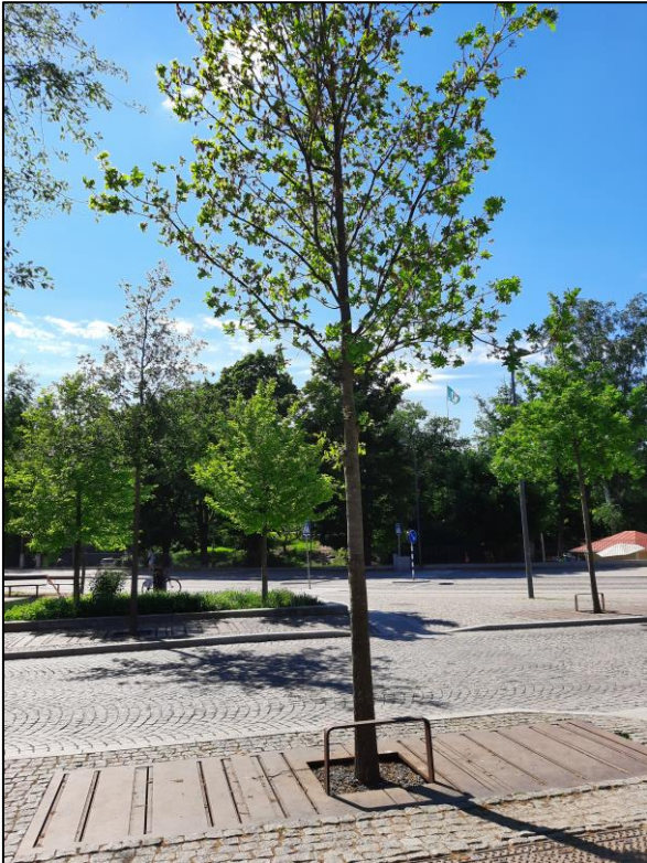
Figur 7.3 Trädplantering i Skelettjord vid Norra Djurgårdsstaden i Stockholm. Foto: NIRAS
