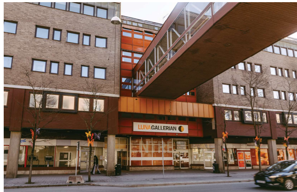
Bild 1. Nygatan med gångbro som sammanlänkar Lunagallerian och S:ta Ragnildsgatan. Källa: Södertälje kommun
