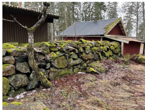
Figur 101 Norrlöt 1:3, mur som löper över Norrlöt 1:2 och 1:3
