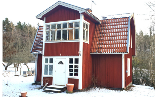
Figur 22 Karlsborg, Vinberga 1:15, byggnad nr. 1
