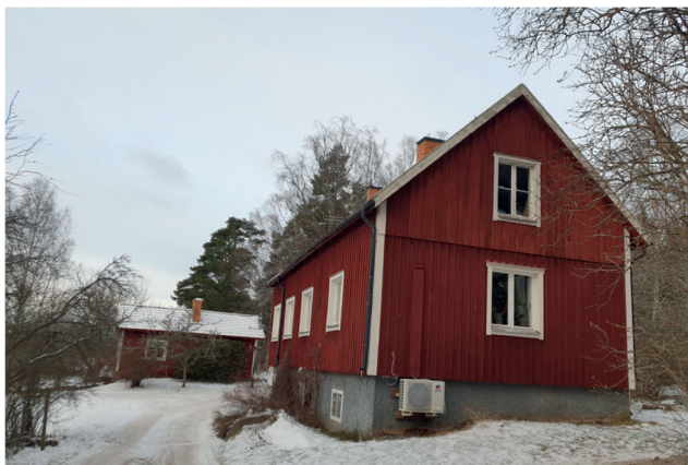
Figur 18 Vinberga 3:1, byggnad nr. 3
