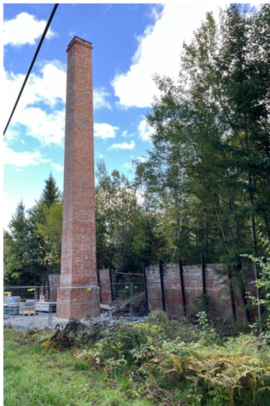
Figur 111 Skorsten tillhörande tegelbruket på Väsby 1:92., nr. 1.
