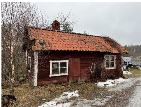
Figur 46 Vinberga 1:11, byggnad nr. 1
