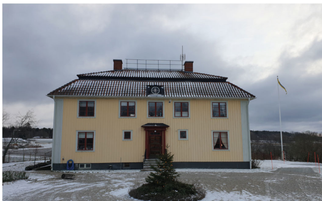
Figur 6 Huvudbyggnad, byggnad nr. 1
