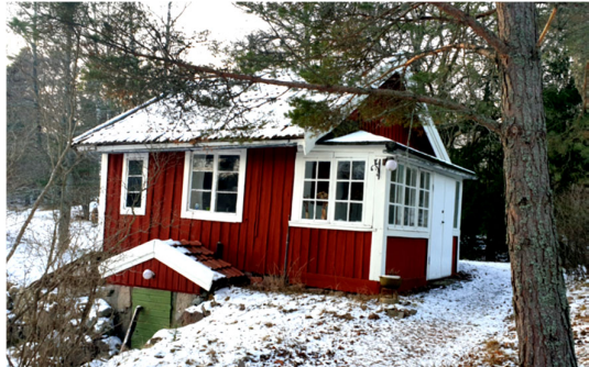
Figur 24 Karlsborg, Vinberga 1:15, byggnad nr. 3
