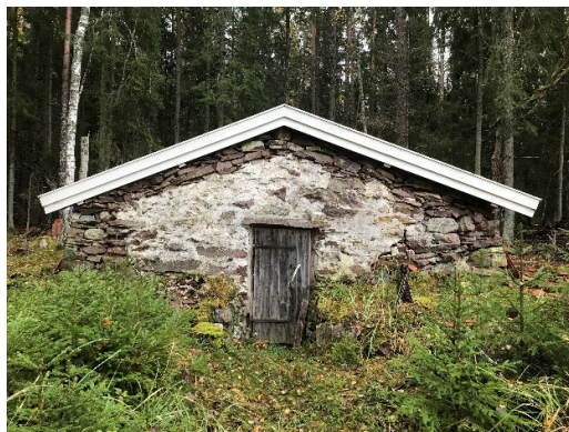
Figur 98 Furudal, Norrlöt 1:26, jordkällare
