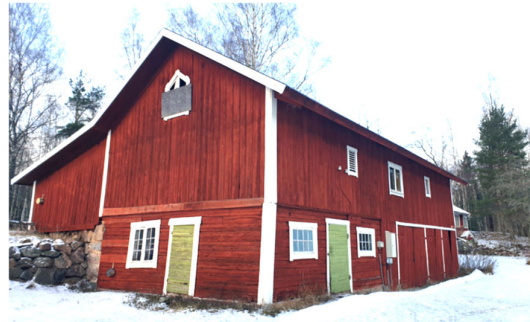
Figur 23 Karlsborg, Vinberga 1:15, byggnad nr. 2
