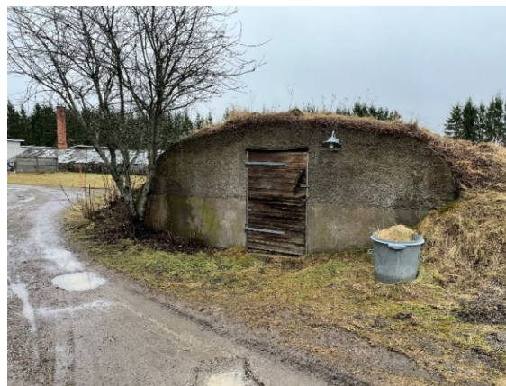
Figur 58 Brännatorp 2:3 med Jordkällare
