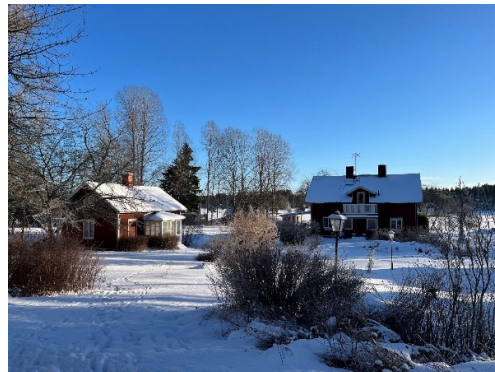
Figur 75 Byggnader på Björnfoten 1:6, Gustenlund. Till höger är huvudbyggnaden nr. 2.
