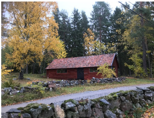
Figur 94 Verkstadsbyggnad nr. 2 och mur
