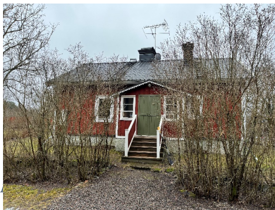
Figur 40 Backa, Vinberga 1:20, huvudbyggnad, byggnad nummer 1
