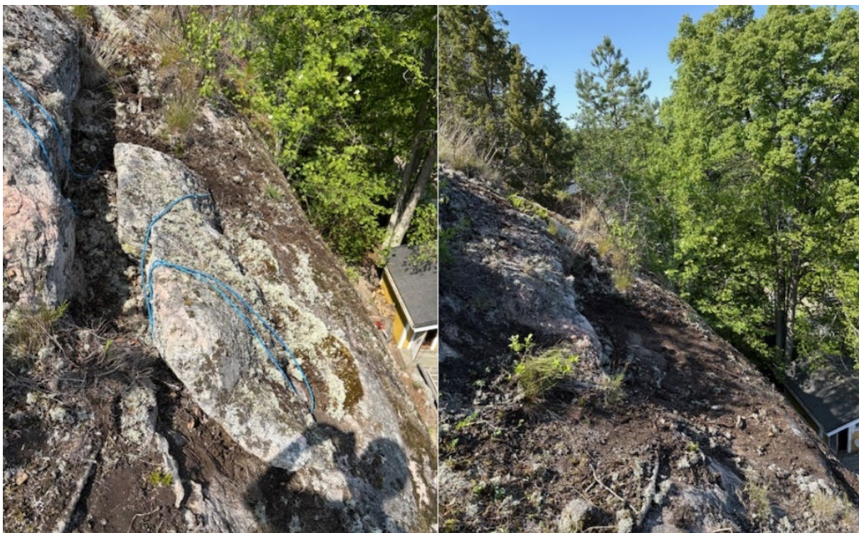
Bild 2–3: Löst block som tagits ner ovan Vinberga 1:43
