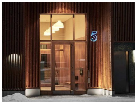
Genom tydlig uppglasning, generös takhöjd, indrag och belysning blir entréerna en tillgång för gaturummet. Arkitekt: sandellsandberg. Foto: Åke E:son Lindman.
