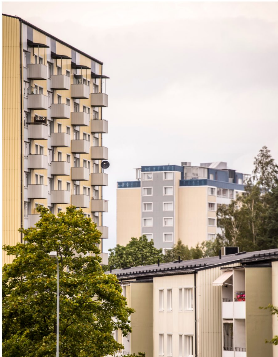
Brunnsäng utgör idag en samlad bebyggelse med 50- och 60-talskaraktär. Bostadsbebyggelsen spänner från villaskala till tolvvåningshus och har en relativt samlad material och kulörpalett som går i gult och beige. Klarblå används återkommande som accentfärg.
