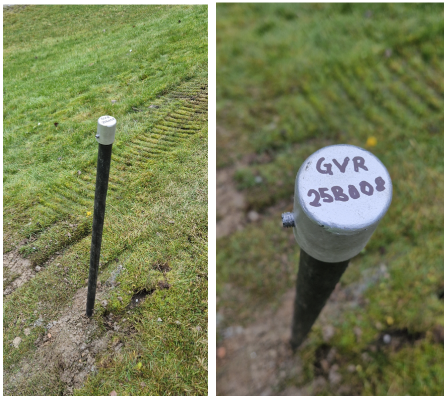
Figur 1. Installerat grundvattenrör i 25B008.
