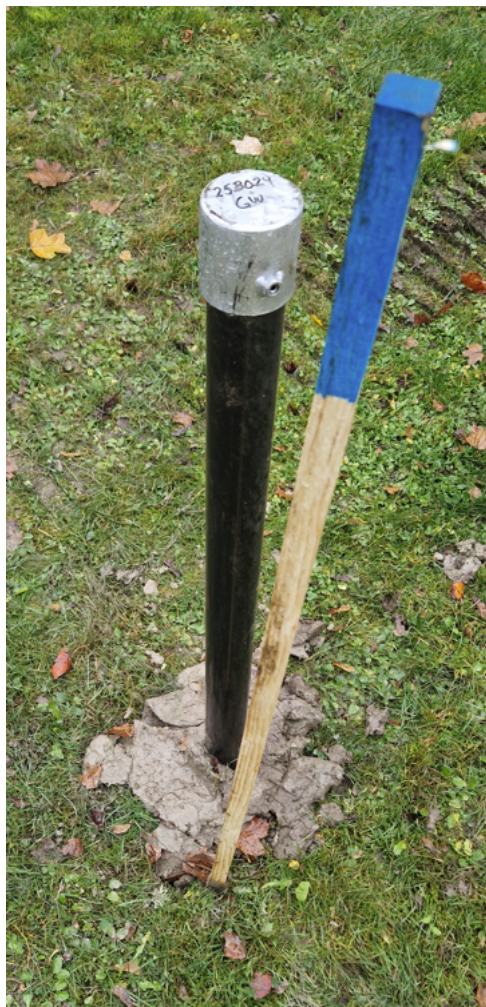
Figur 1. Installerat miljörör i 25B024.
